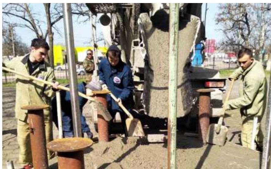
Рисунок 2.5. Бетонирование основания
